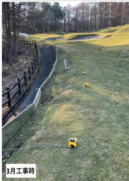
4番ホールの土留め柵が、ここ数年で少しずつカート道路側にせり出しており、今後、柵の決壊により土砂が流出し、コースが崩落する可能性が懸念されています。3月には2023年度シーズン中に、これ以上土留め柵がカート道路側にせり出さないよう応急的に補強工事を行いました。懸案事項を解決する為、土留め柵の補強と併せて、隣接するカート道路の嵩上げを行います。（カート道路の嵩上げについては、道路の傾斜を緩和し安全性を高めることと、土留め柵のみにかかっていた重量を道路にも分散し支えることを目的としています。）工期といたしましては来期の営業開始に支障をきたさないよう、11月13日（月）より11月30日（木）迄を予定しています。
